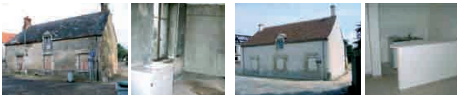
Maison à Saint Prvé, avant et après travaux.
