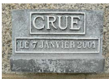
Repère de crue (janv. 2001) Redon Quai Duguay Trouin
