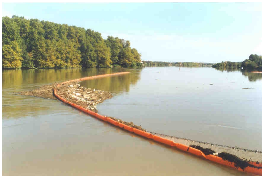
Photo 1 : Barrage flottant installé sur le bras gauche de l'île de Berenx sur l'Adour (cliché : Institution Adour)
